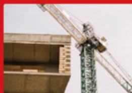
Instalación de grúa torre de gran tamaño
